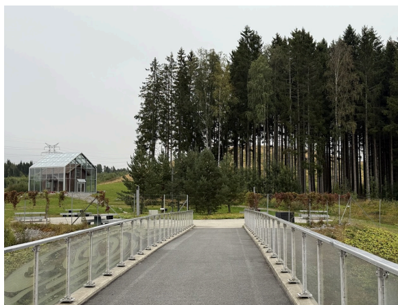
Figur 69: gangbro over til rasteplass, Jaren . Foto: Norwaste
